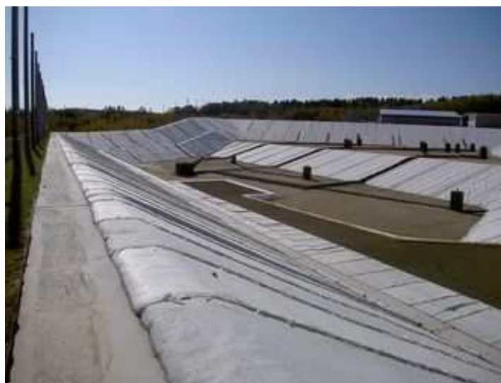
最終処分場（埋立地）※写真は供用開始前
