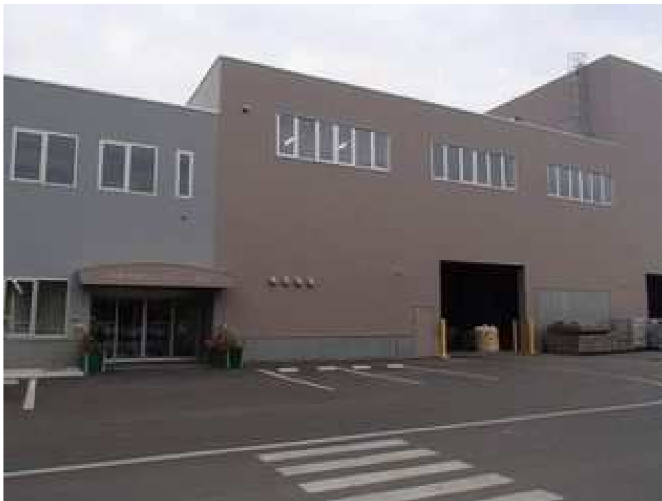
破碎・リサイクル施設
