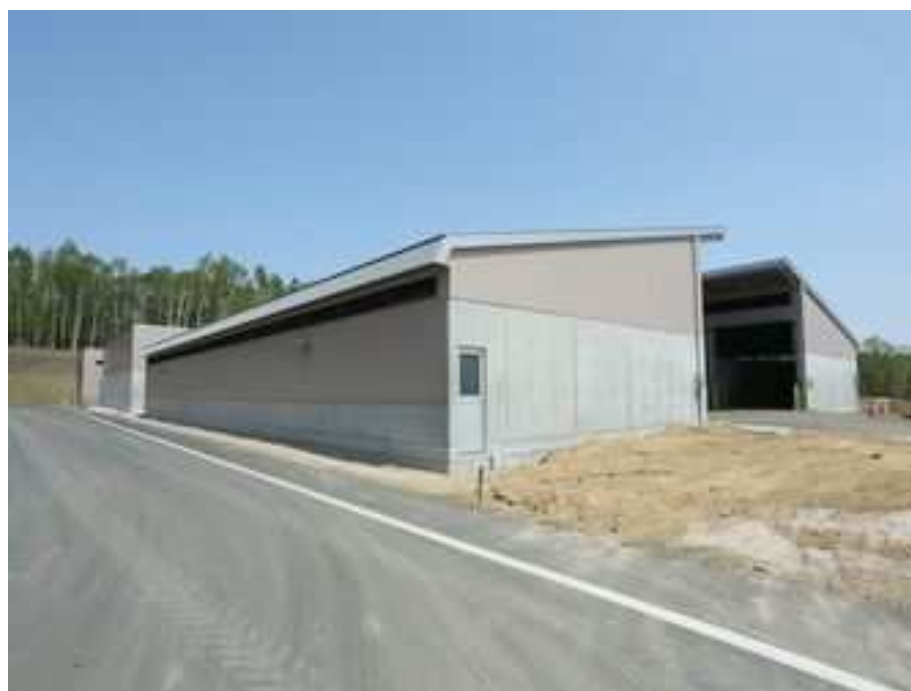
生ごみ堆肥化施設
