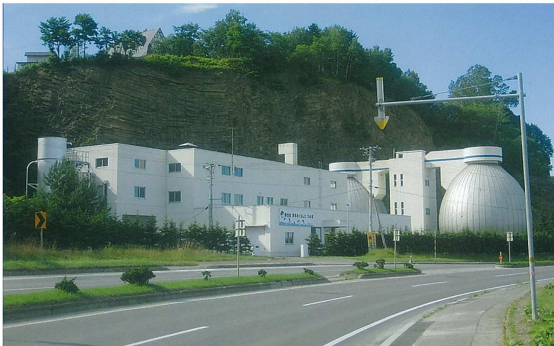
網走市スラッジセンター
