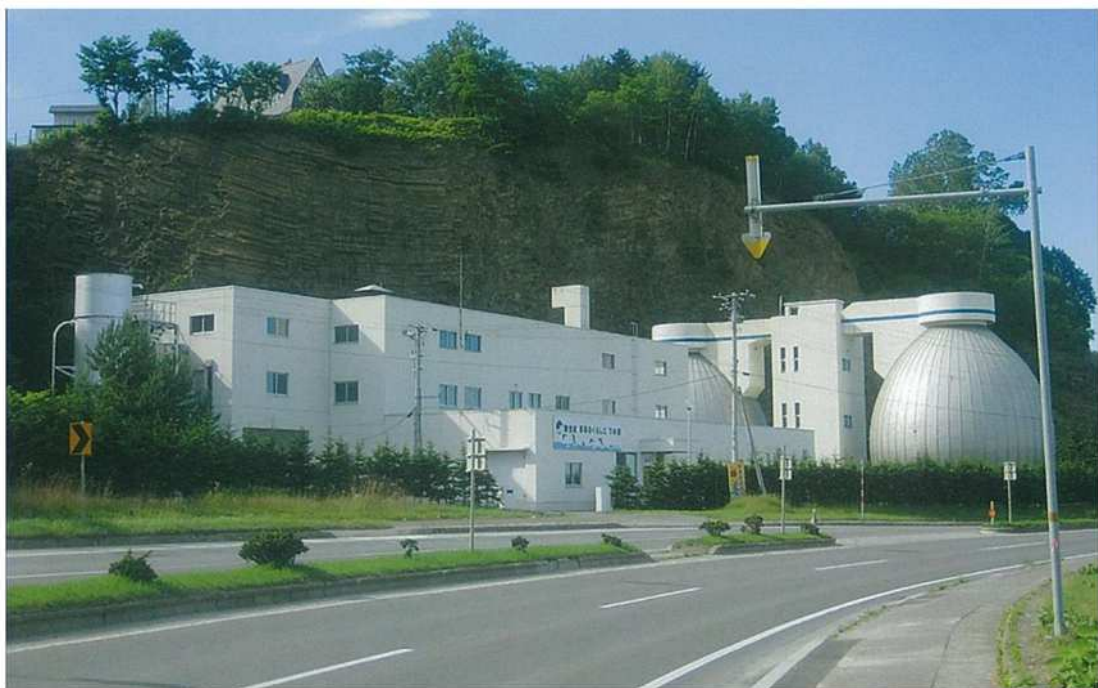
網走市スラッジセンター
