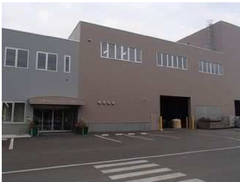
破碎・リサイクル施設
