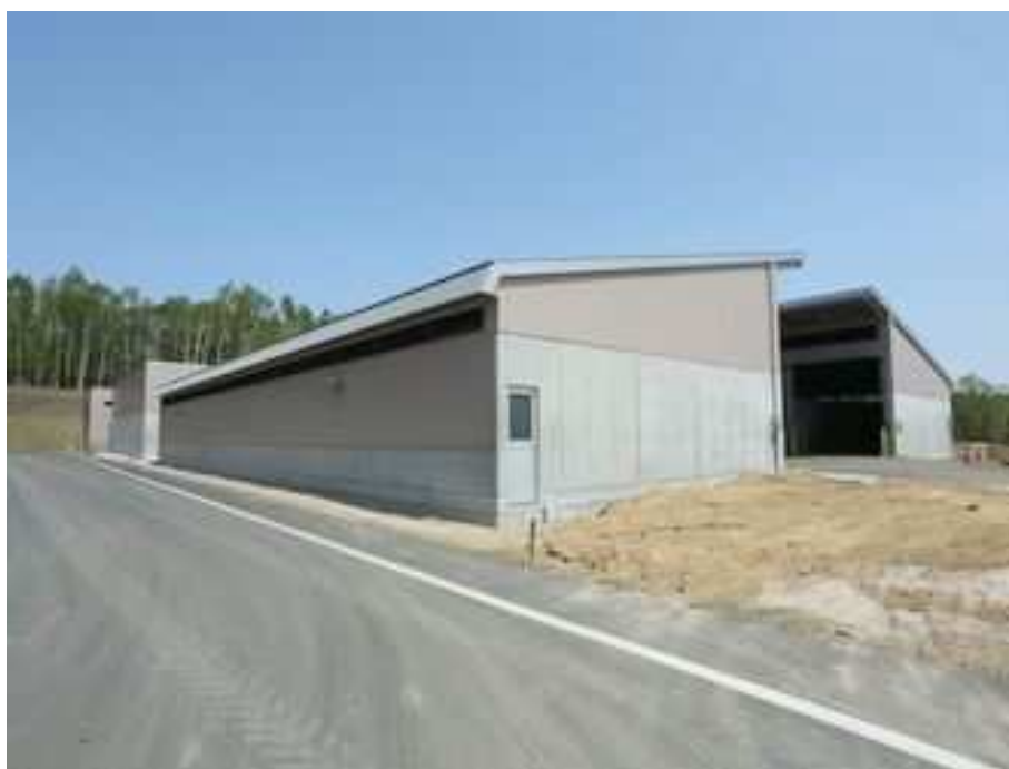
生ごみ堆肥化施設
