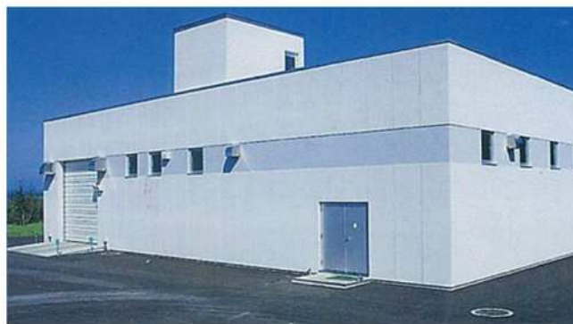
網走市二見ヶ岡クリーンセンター
