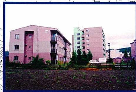
大曲の公営住宅団地
