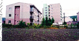
大曲の公営住宅団地
