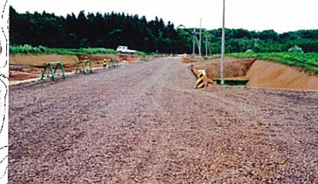
道路を整備中
