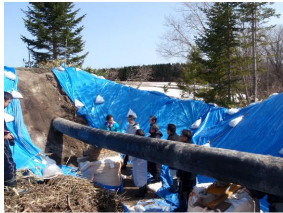
漏水現場視察
