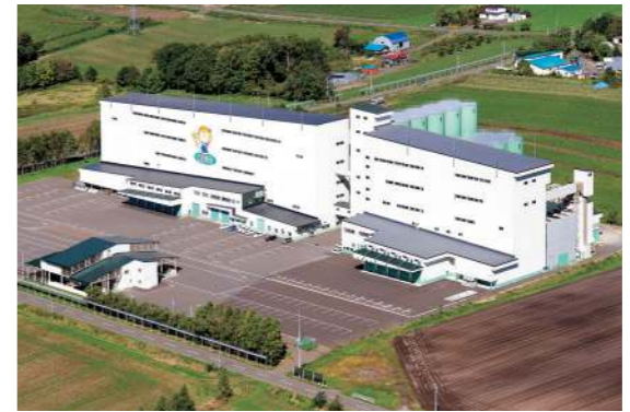
網走市麦類乾燥調製貯蔵施設
