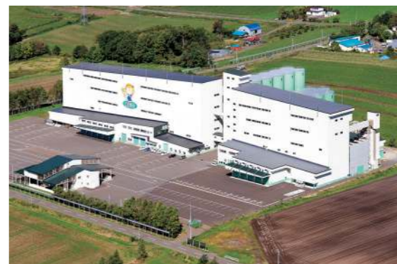
網走市麦類乾燥調製貯蔵施設
