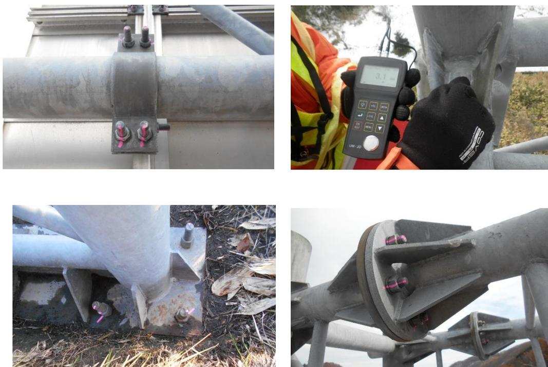
点検は、近接目視に加え必要に応じて触診や打音等の非破壊検査を実施します。また、施設内の照明等附属物本体や取付金具類の点検も実施する。
