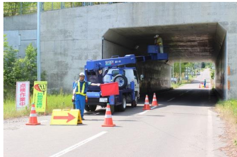
写真-2 大型カルバート点検状況
