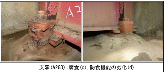
支承(A2G3):腐食(c),防食機能の劣化(d)
