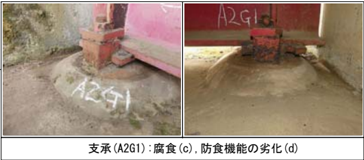
支承(A2G1):腐食(c),防食機能の劣化(d)
