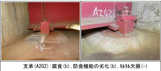
支承(A2G2):腐食(b),防食機能の劣化(b),モルタル欠損(-)
