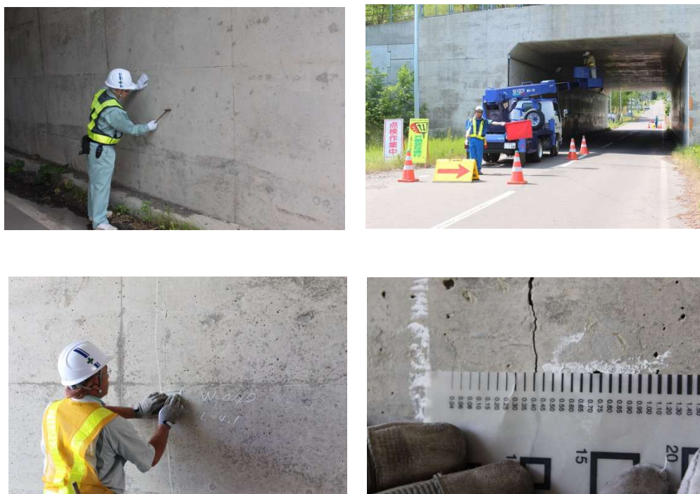
写真－2 大型カルバート点検状況
