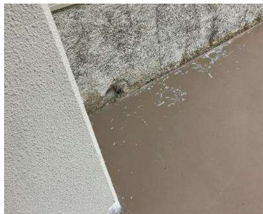
＜漏水による体育館内壁の破損＞
