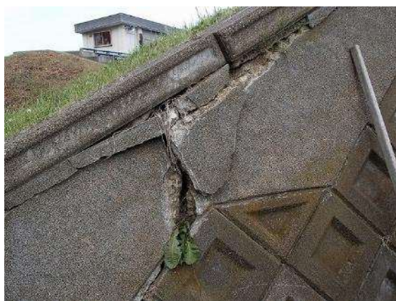
<擁壁の破損>
