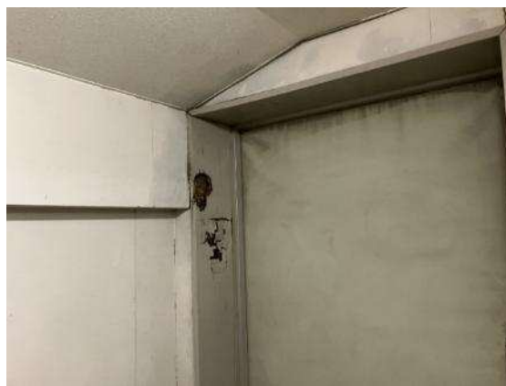
＜漏水による建具枠の破損＞
