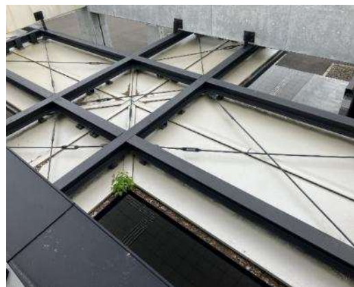
＜底の排水側溝の詰まり＞
