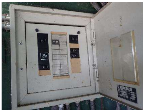
<電灯分電盤の劣化>
