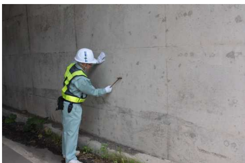
写真－2 大型カルバート点検状況
