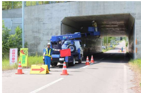
写真－2 大型カルバート点検状況
