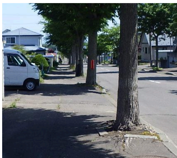
発達した樹根による歩道の変形
