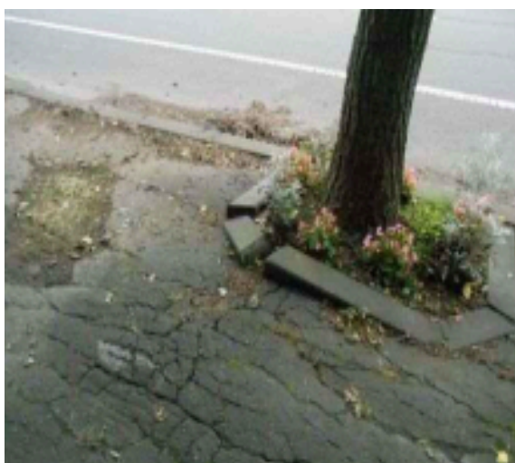
発達した樹根による歩道の変形
